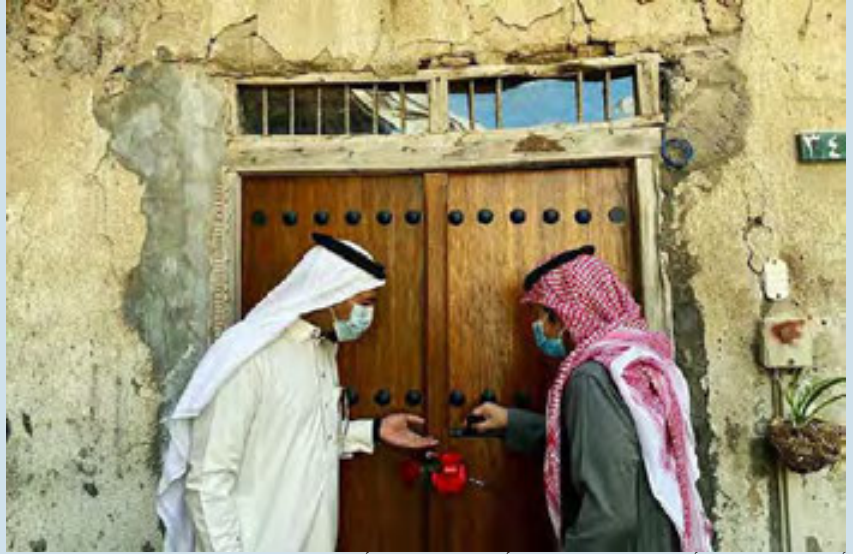
أمانة الشرقية أثناء عملية ترميم أحد المباني الأثرية في تاروت
