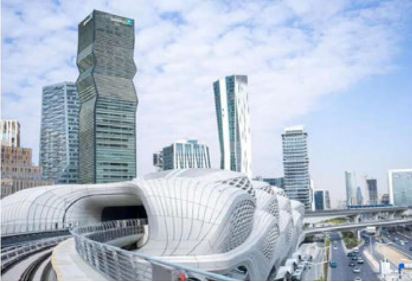
محطات القطار تجمع بين الهندسة الحديثة والعمارة القديمة
